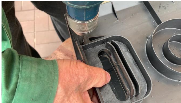
4. Высверливаем отверстия под саморезы для крепления переходника
