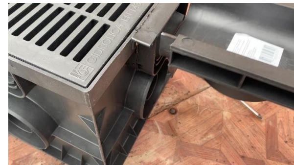
8. Заводим торец лотка в переходник и место стыка также герметизируем
