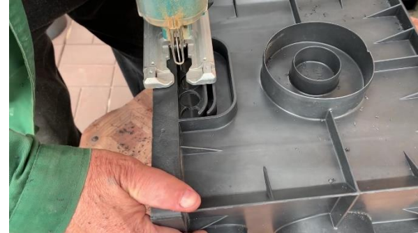
3. Такое же отверстие вырезаем и в дождеприемнике
