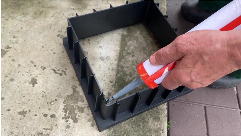
1. Наносим герметик по периметру нижней части надставки
