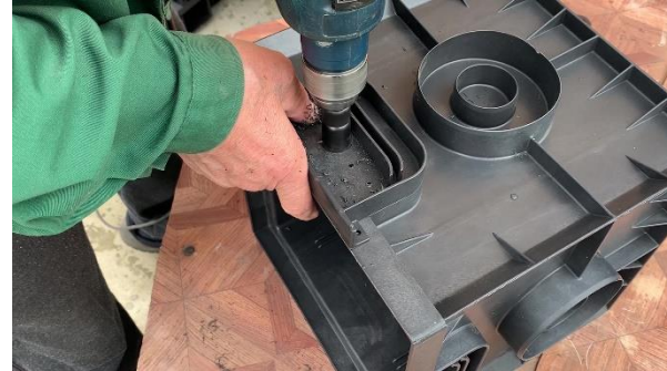
2. Вырезаем отверстие в переходнике под нужную высоту лотка
