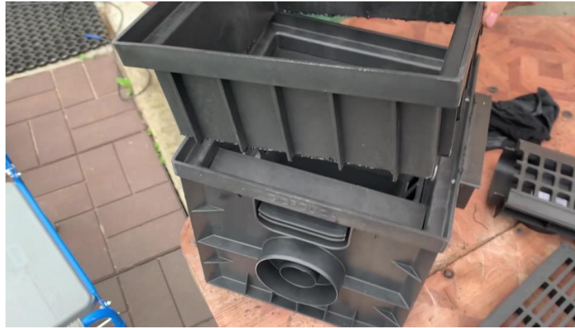
2. Устанавливаем надставку на верхнюю часть дождеприемника
