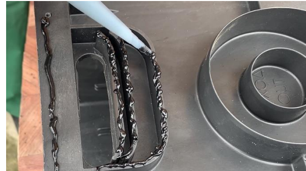
5. Герметизируем место соединения переходника и дождеприемника
