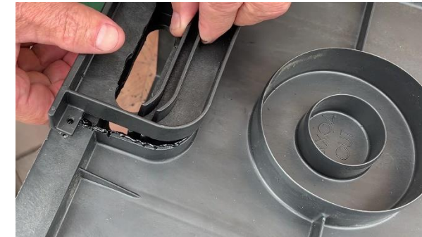
6. Стыкуем на герметик переходник
